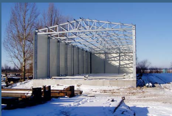
Licht maar solide. Elk onderdeel kan door 2 personen verplaatst worden. Alle onderdelen passen in elkaar als een gigantisch bouwpakket.
